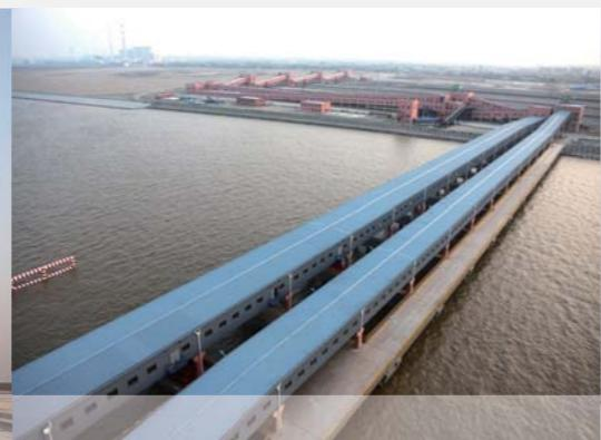
Система конвейера включает в себя 36 ленточных конвейеров с общей длиной 11 км и 12 трансферных станций
