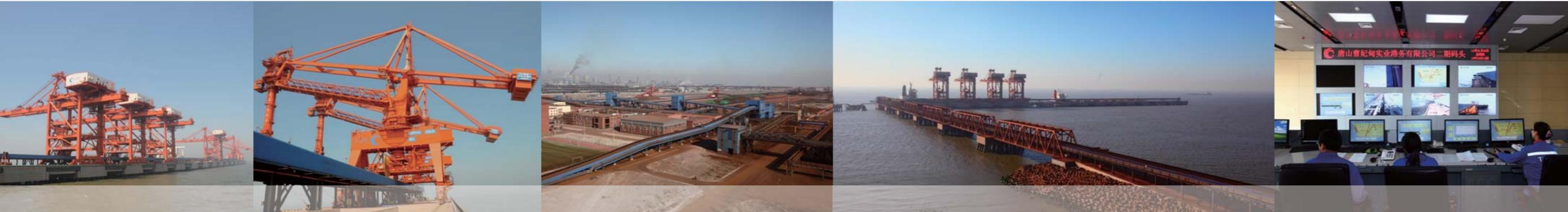
4 единицы судопогрузчиков с производительностью 3200 т/ч, подъёмным весом 72 тонны и вылетом стрелы 47 метров
